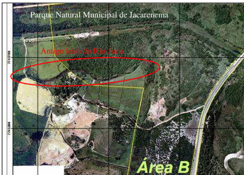
Figura 117: Área proposta para o descarte dos efluentes tratados das futuras casas do Royal Park Jacarenema Extraída do Parecer Técnico 08/11 da Secretaria Municipal de Meio Ambiente
